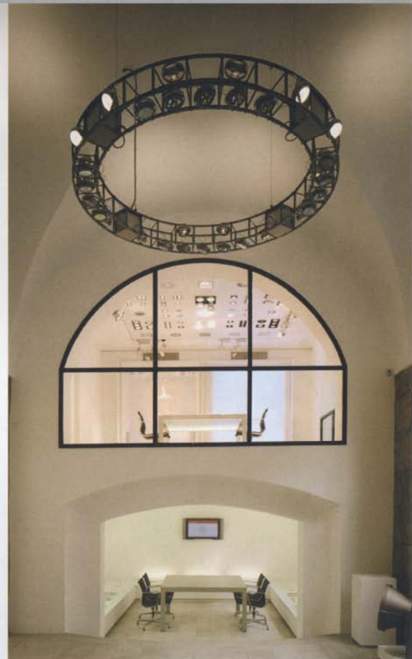
AMPIEZZA Tubazioni installate sulle volte portano gli impianti antincendio, antifurto e tutti gli impianti speciali
